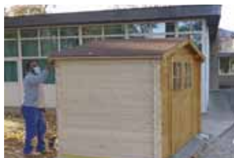
Remplacement du chalet et création d'un local de stockage.
