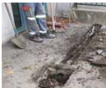
Travaux de maçonnerie et d'assainissement pour l'évacuation des eaux pluviales.
