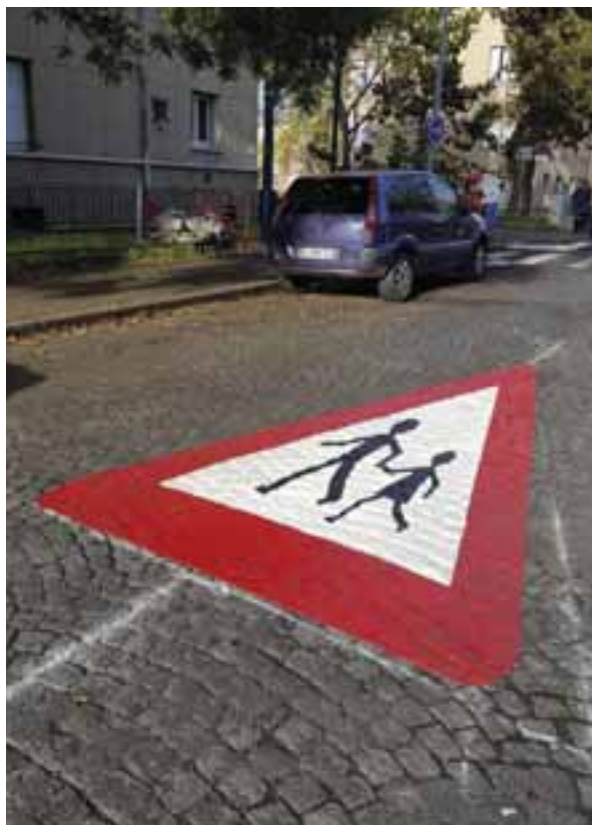
Renforcement de la signalisation des passages piétons aux abords des écoles.
