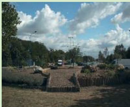
2 ème phase : mise en place d'enrochement et plantation des éléments
