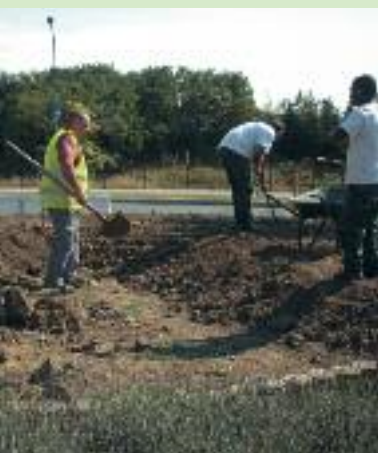
1 ère phase : remplissage de terre végétale
