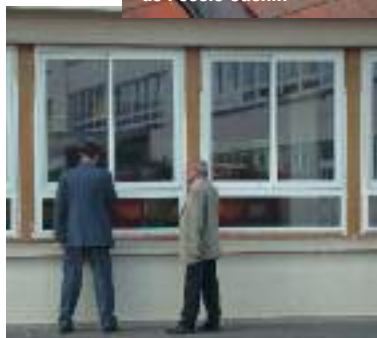
Remplacement des menuiseries de l'école Jean Jaurès
