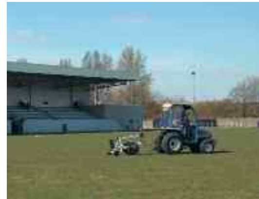
Travaux sur le terrain d'honneur.
