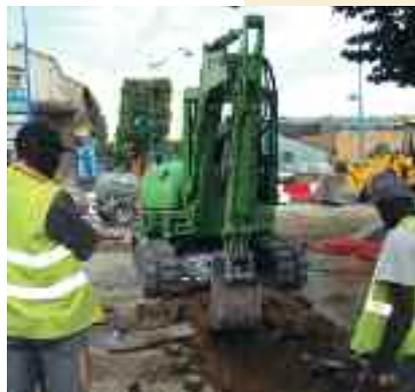
Travaux d'assainissement avec la pose de tuyaux et de raccords.
