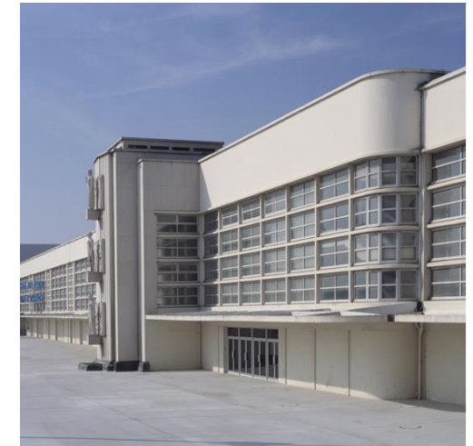
Détails de la façade de l'aérogare Source : Ministère de la Culture
