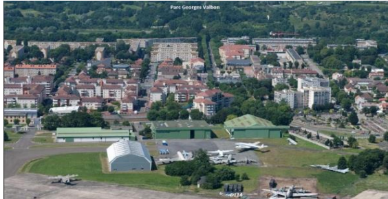
Vue aérienne de la façade ouest de l'aéroport, source : APUR
