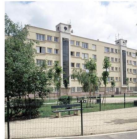
L'ensemble HBM du Pont-Yblon (source : Ministère de la Culture)
