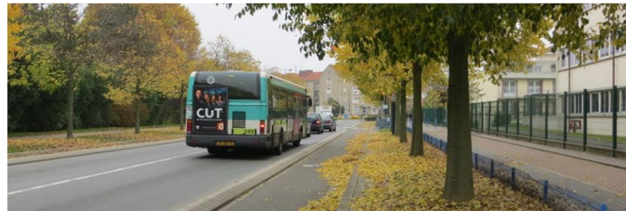
La RD 114 côté sud, requalifiée en boulevard urbain Source : Even conseil
